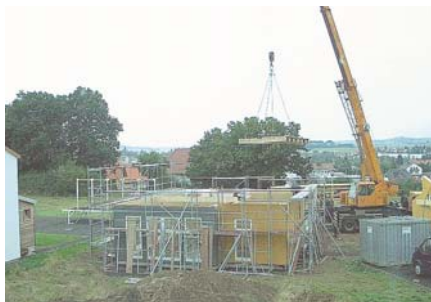
Bild 5: 12.00 Uhr: Das Erdgeschoss ist fertig, die Decke wird aufgelegt
