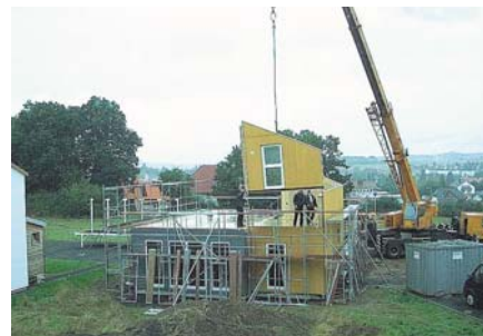
Bild 6: 15.00 Uhr: Montage des Dachgeschosses
