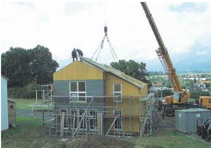
Bild 7: 19.00 Uhr: Verlegen des letzten Dachelementes
