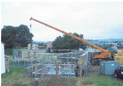
Bild 4: Morgens auf der Baustelle: vorbereitete Bodenplatte mit Gerüst
